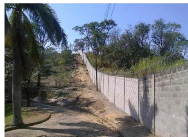
Muro da Unidade de Vinhedo, construído a partir da campanha de captação de recursos.
